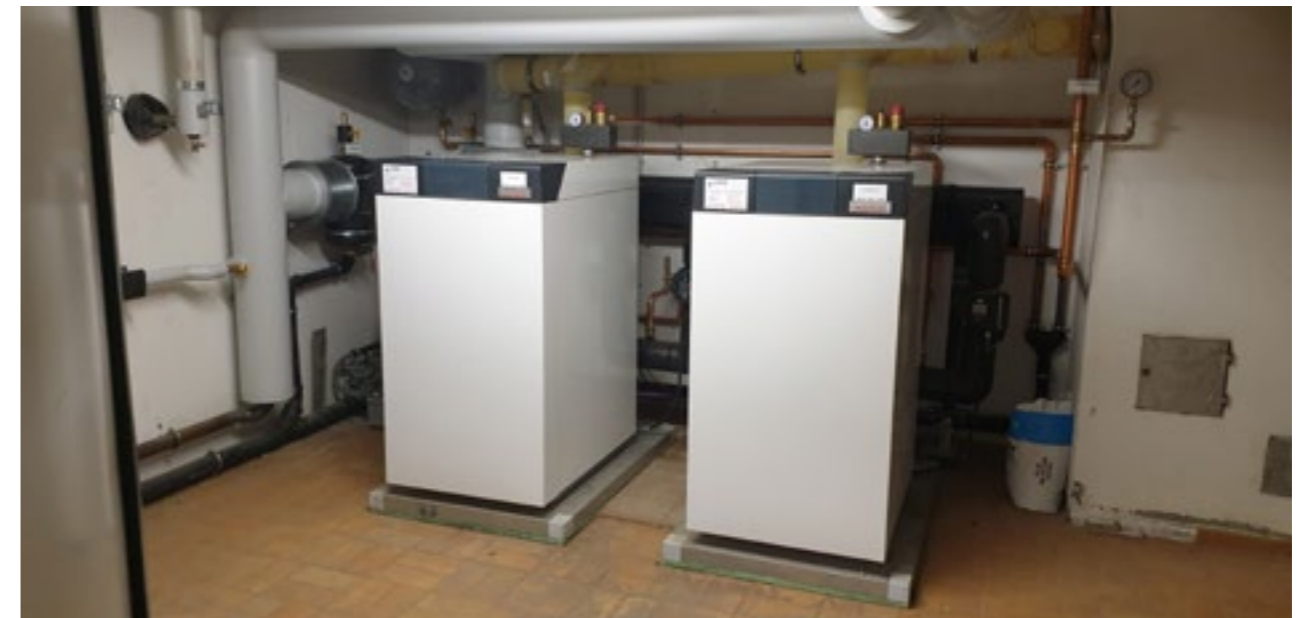
Erneuerte Heizungsanlage im Wilhelm-Busch-Ring
